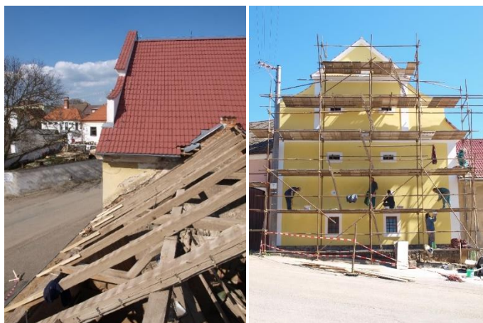
Rekonstrukce budovy kanceláří a muzea
